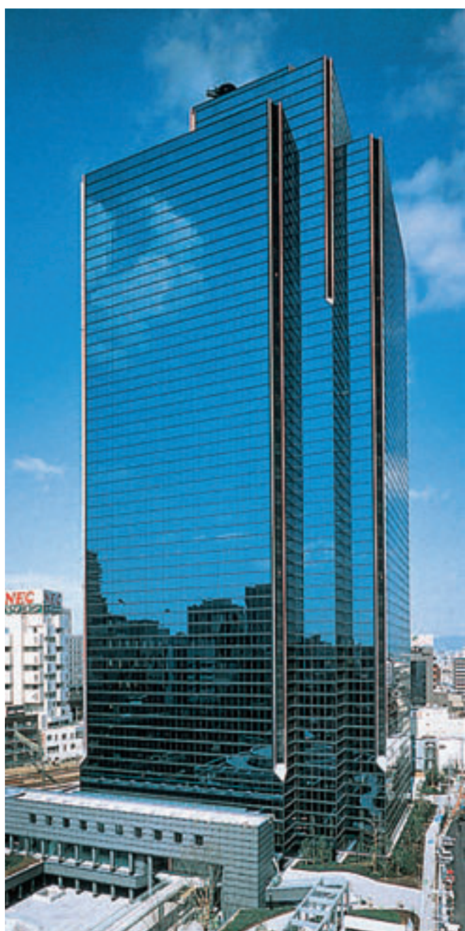
Штаб-квартира DAIKIN INDUSTRIES Ltd, Осака, Япония
